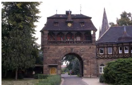
Abb.13: Aus heimischem Buntsandstein gebaut: Torhaus des Schlosses Vitzenburg.
